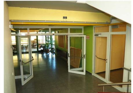
*In allen Geschossebenen wurde das Stiegenhaus mit selbst schließenden Brandschutzelementen abgeschottet. Eine Brandrauchentlüftungsanlage wurde eingebaut.*
